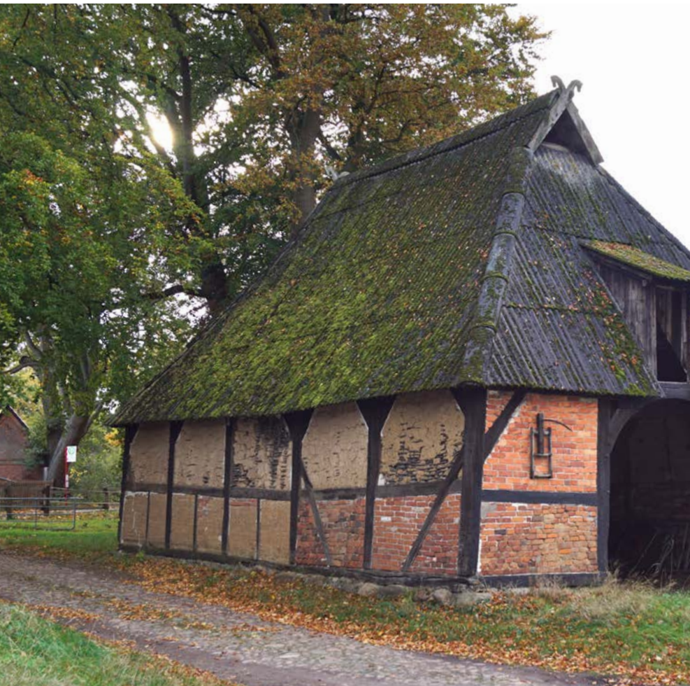
Bei diesem historischen Schafstall wurde das Dach mit Faserzementplatten gedeckt. Bei der Sanierung erhielt er wieder ein Reetdach.
