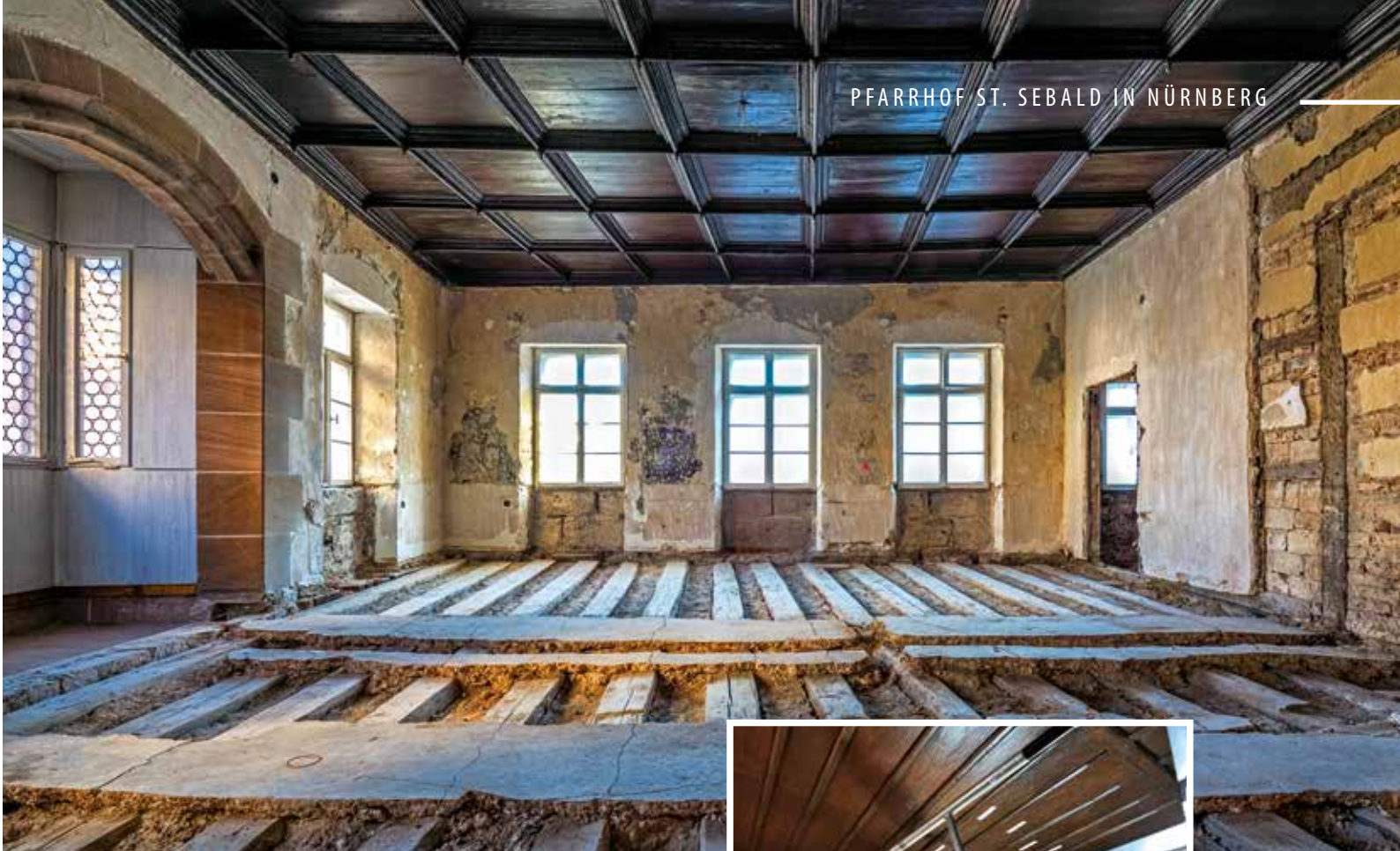
Oben und rechts: Kassettendecke vor und Leistendecke während der Restaurierung, sanierte Fassade Ostflügel
