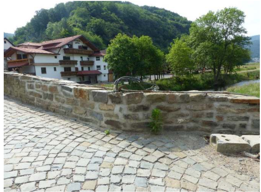
Brückeneinfahrt West: fehlende Rollierungslage auf der rechten Brüstung im Bild (Schadstelle)
