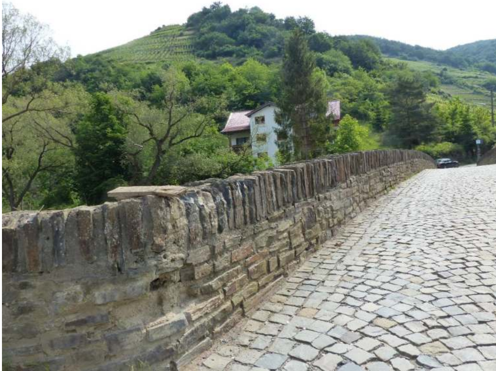
Brückeneinfahrt West: fehlende Rollierungslage auf der rechten Brüstung im Bild (Schadstelle)
