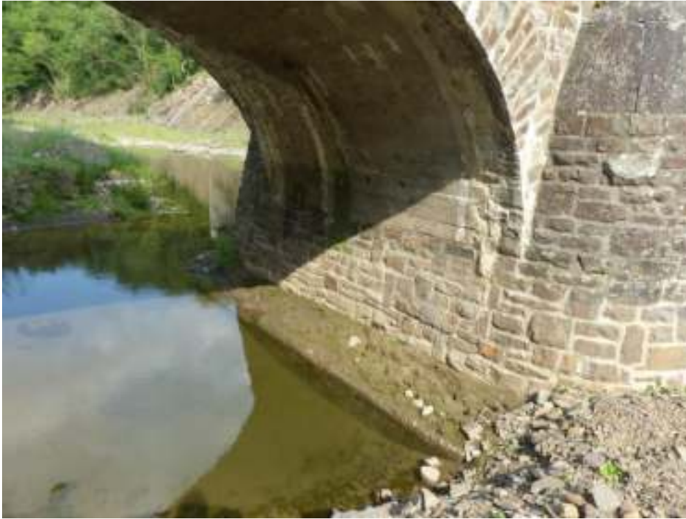
Pfeiler 2, rechtes Ufer, Fundamentvorlage erkennbar
