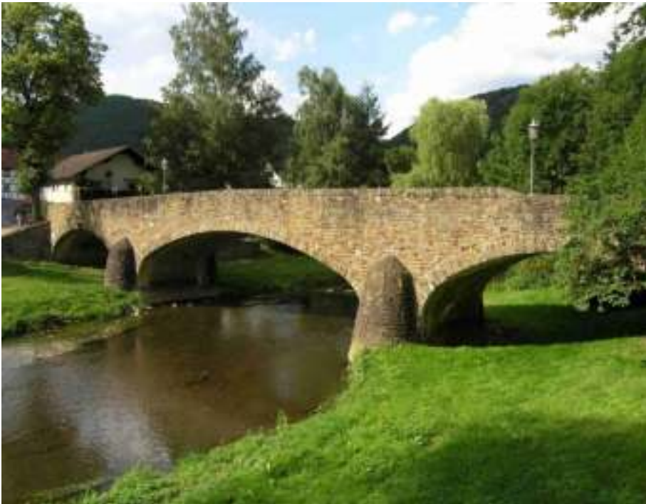
Bild 2: Domhofbrücke Schuld, Zustand vor dem Hochwasser 2021. Zeitpunkt und Autor der Aufnahme unbekannt. Entnommen aus: https://www.aw-wiki.de/w/index.php?curid=5013
