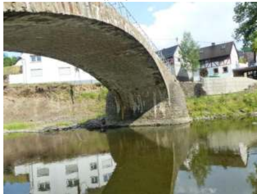
Mittlere Brückenöffnung - Südseite
