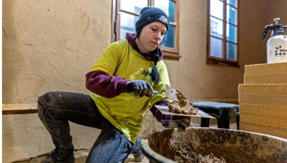
Freiwillige der Jugendbauhütten helfen vor Ort nach dem verheerenden Hochwasser.
