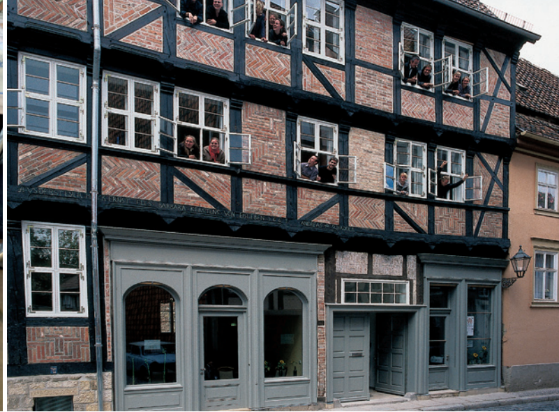
Wohn- und Seminarhaus der Jugendbauhütte Quedlinburg
