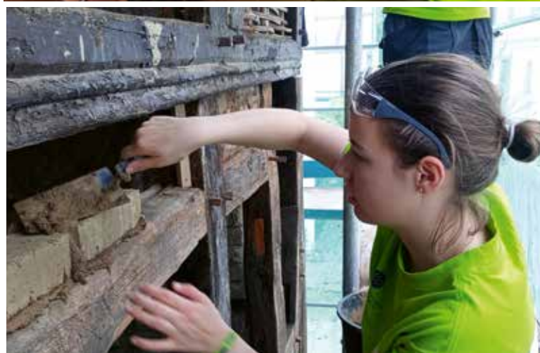
von oben nach unten: Feingefühl auf der Reeperbahn, Reeperbahn-Erprobung des fertigen Seils, Schmieden am Tag des offenen Denkmals®, Lehm- und Ziegelbau im Ahrtal,
