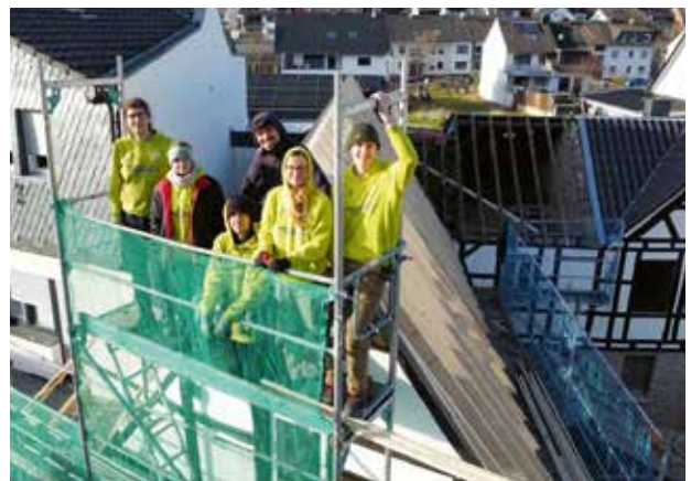
Ein neues Dach für die ehemalige Synagoge Dernau
