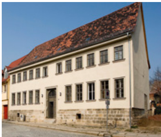
Zur Wiederherstellung des einladenden Gästehauses Goldstraße gehörte die Instandsetzung aller historischen Fenster.
