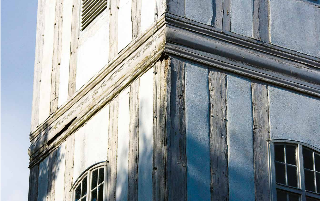
Holz statt Stein: Erst bei näherer Betrachtung ist der Fachwerkbau der Dorfkirche in Plänitz gut zu erkennen.
