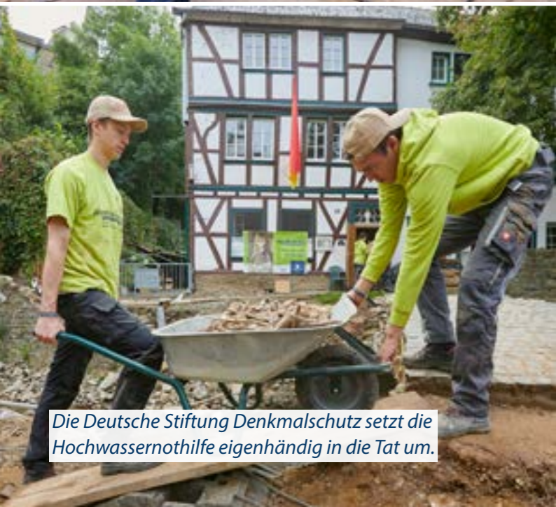
Sachverständige der Deutschen Stiftung Denkmalschutz helfen bei der Beurteilung von Flutschäden.
