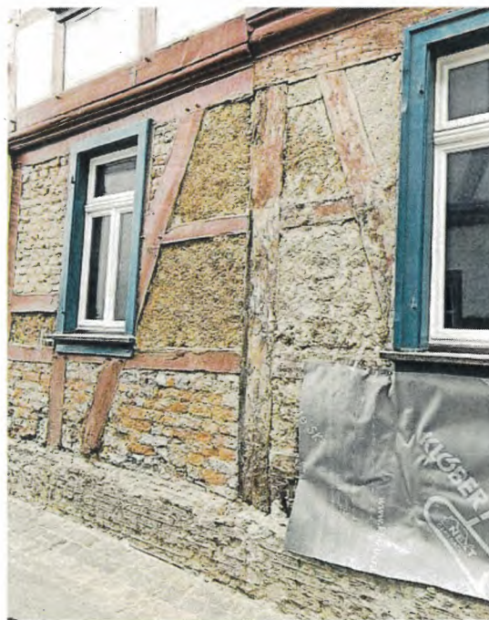
Das Fachwerkhaus der Familie Tils in der Ahrweiler Oberhutstraße wird vom Fluthilfecamp der Jugendbauhütten nach der Flut restauriert. FOTO: DSD
