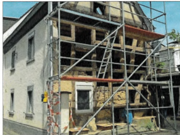
Das Fachwerkhaus in der Pützgasse.
